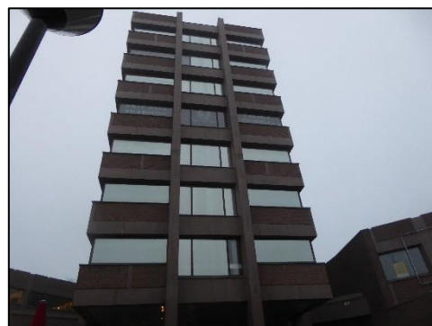
Het hoge gedeelte van het gebouw;
