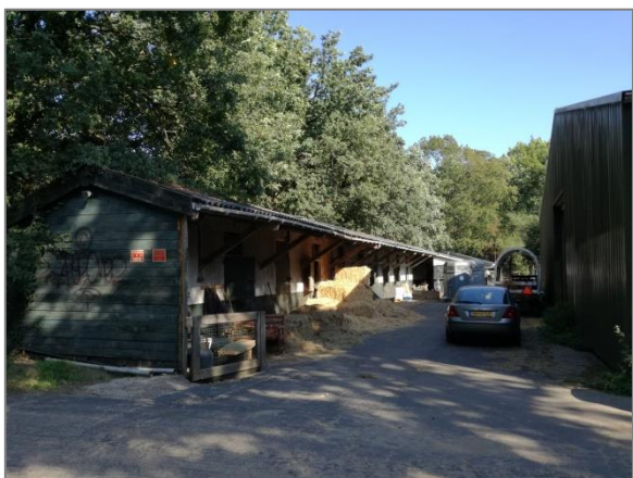
Afbeelding 2.3 | Losstaande sectie stallen naast het manegegebouw
