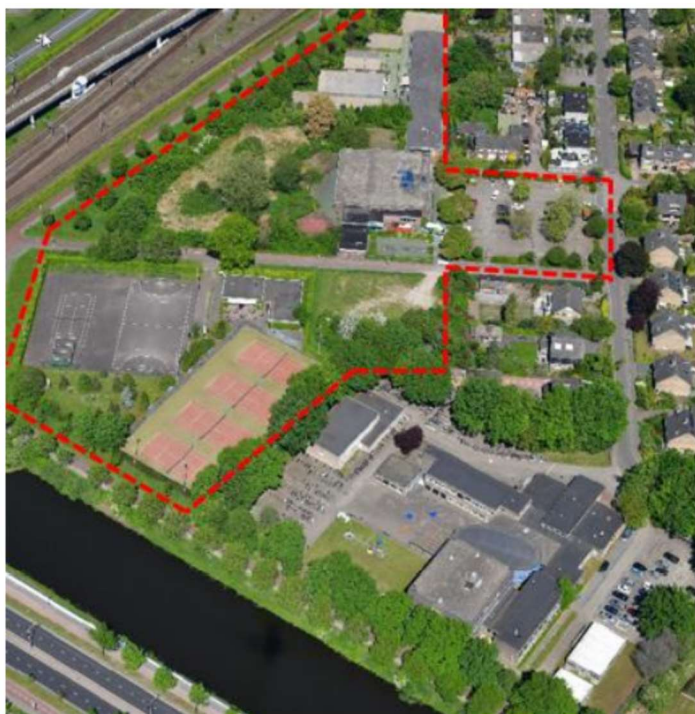
Vogelvluchtfoto bestaande situatie (voor sloop zwembad)
