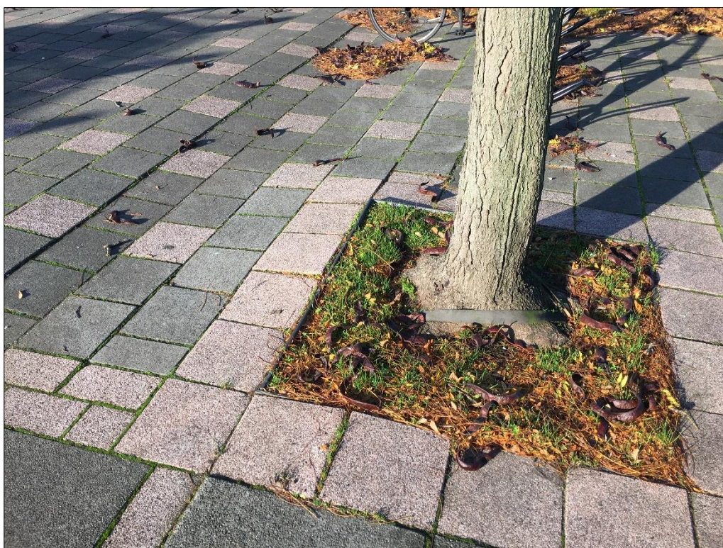
Afbeelding 7: Verhardingsopdruk rondom te kleine boomspiegel (en verzakking door toepassing van bomenzand?);
