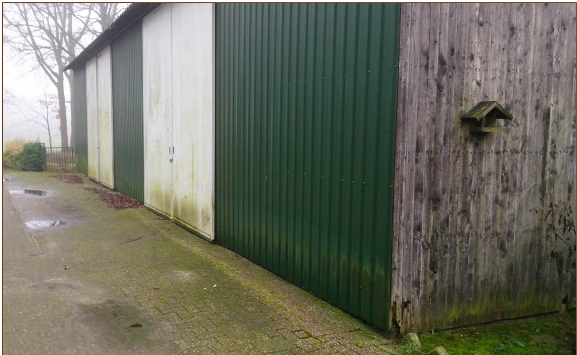
Foto 1. De schuur waar de kerkuilenkast hangt aan de binnenzijde. Via een opening in de gevel is de kast bereikbaar van buitenaf.
