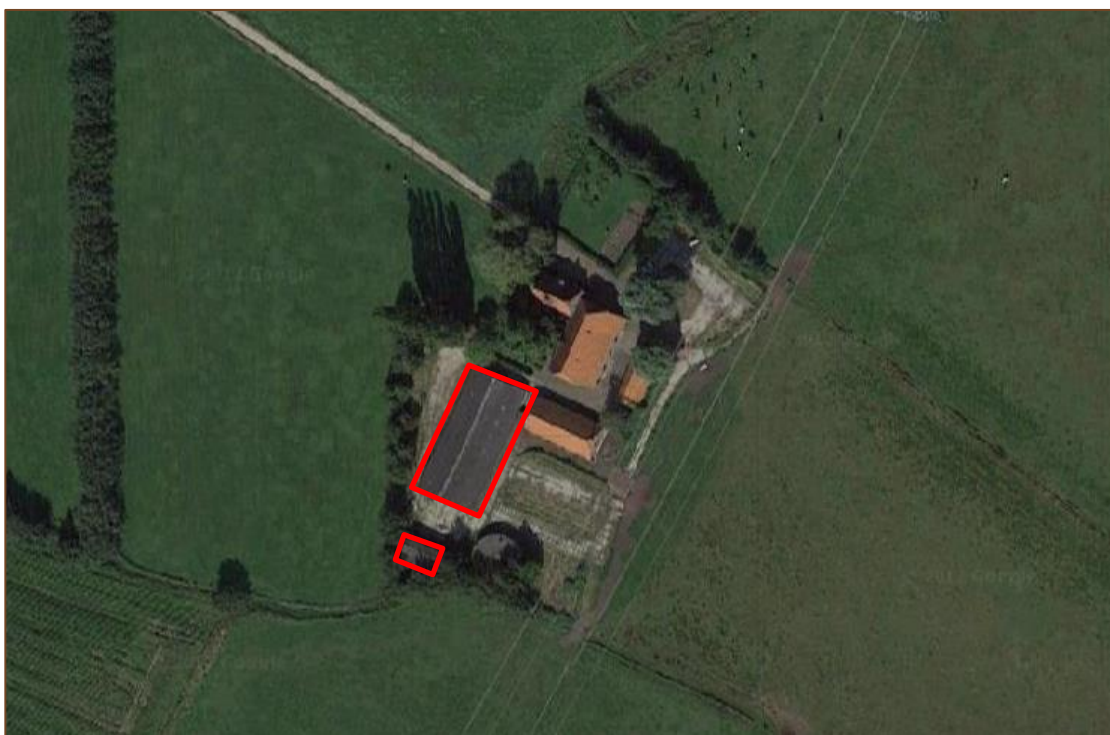
Figuur 2. Luchtfoto van het plangebied Coelhorsterlaan 1 met de te slopen bebouwing (rood), bron: Google Earth, 2017.
