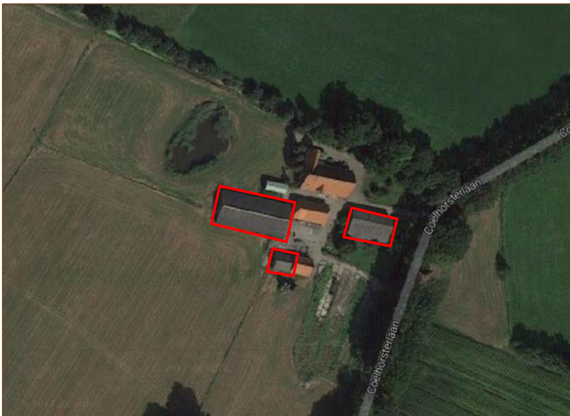
Figuur 3. Luchtfoto van het plangebied Coelhorsterlaan 10 met de te slopen bebouwing (rood), bron: Google Earth, 2017.
