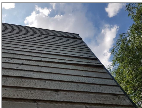
Afbeelding 2.10 | Loszittende gevelbetimmering.
