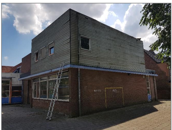
Afbeelding 2.9 | Tweede bouwlaag met gevelbetimmering.
