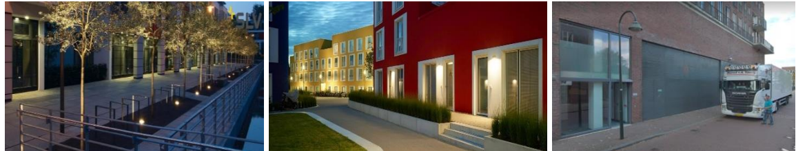
Links en midden: verlichting in de buitenruimte en aan het gebouw. Rechts: laad-losdeur vlak en integraal in de gevel, uitgevoerd in schoepenroosters. Geen borden of zichtbare aanpassingen in de maaiveldinrichting. Deze gevel is nog wel te hard en saai en te veel een achterkant.
