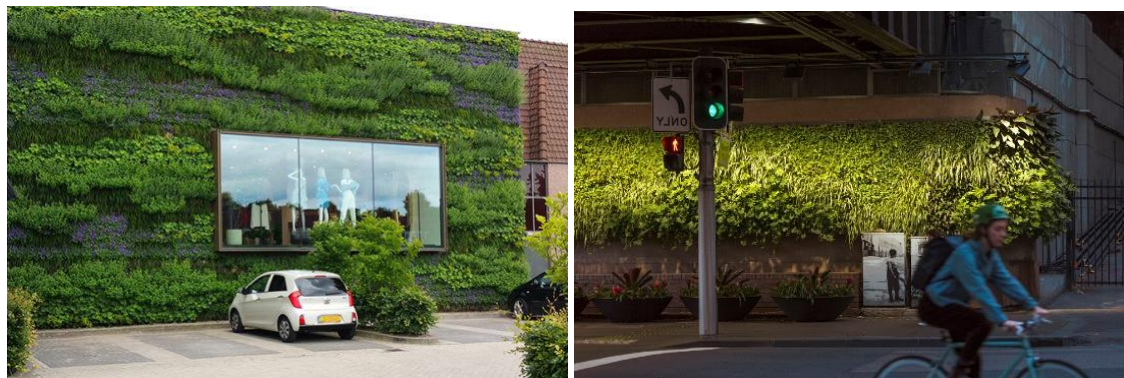
Groengevel als etalage en -mooi aangelicht- in een treinonderdoorgang (!)
