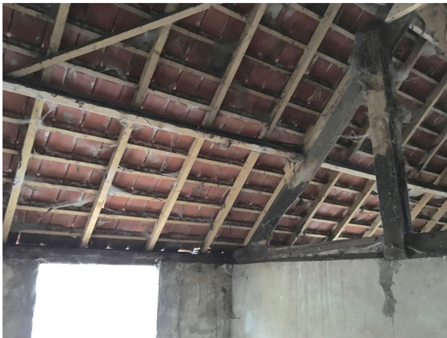
Foto 3.4 Binnenkant stal met pannendak.
