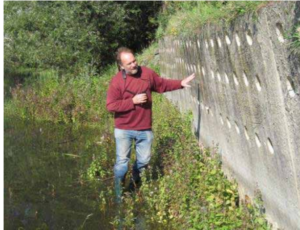
Referentie zwaluwenwand, betonnen keerwand met gaten, erachter is een bult van zandgrond
