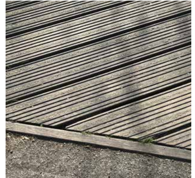
Aansluiting steiger op asfaltroute
