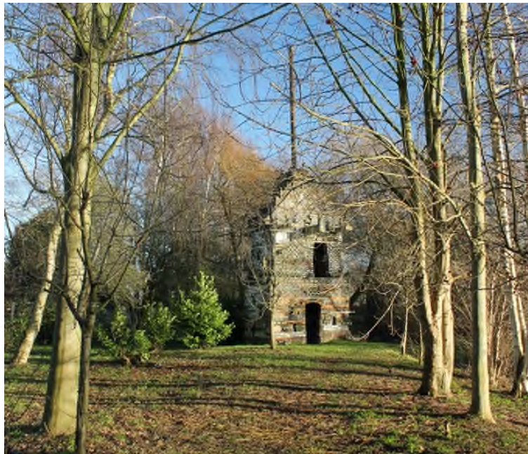
Figuur 2.4: Foto van het 'torentje' naast het bruggetje naar het eiland
