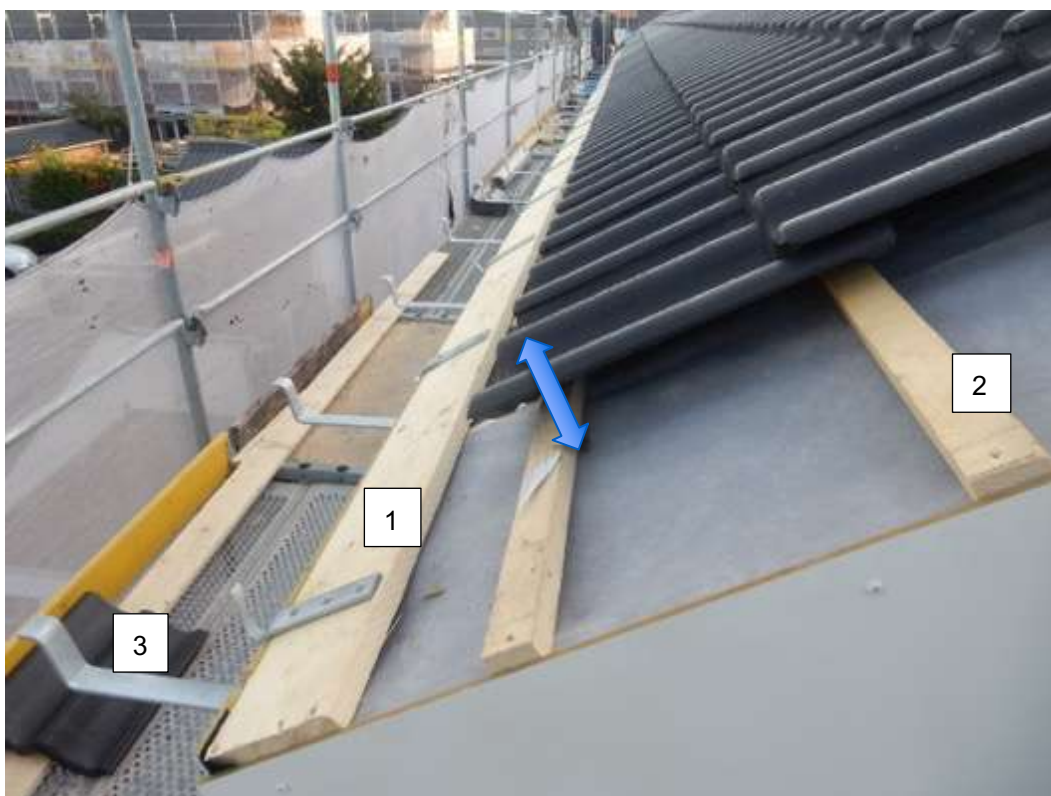
Afbeelding 6.1 Profileren van de ruimte onder de dakpannen (pijl). De onderste rij dakpannen (1) is nog niet geplaatst. De onderste rij pannen ligt straks over de gootplank (3). Er is in de nieuwe situatie evenveel broedruimte als in de oude situatie aanwezig: de panlatten (2) rusten nu op de isolatiebeplating in plaats van het dakbeschot. Uiterst links zijn de beugels voor de ondiepe dakgoot zichtbaar (3). De verticale afstand tussen de bodem van de goot en de ingang onder de onderste rij dakpannen (nog niet geplaatst) is niet te groot voor huismussen. Bij deze situatie is de kopse gevel niet met metselwerk aangeheeld maar afgedekt met trespa. Foto: E-consultancy.
