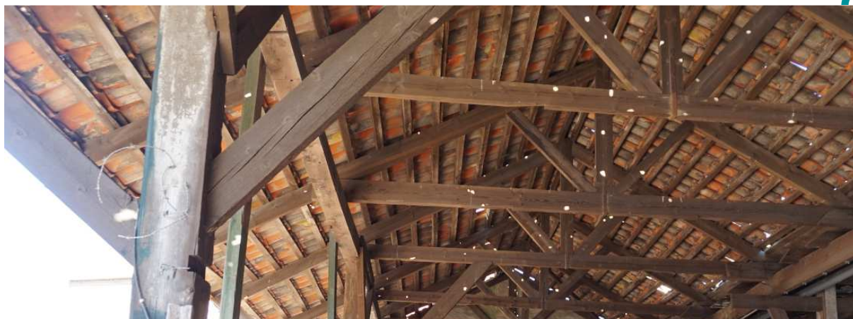
Figuur 5.2. Open dakconstructie half open kapschuur.
