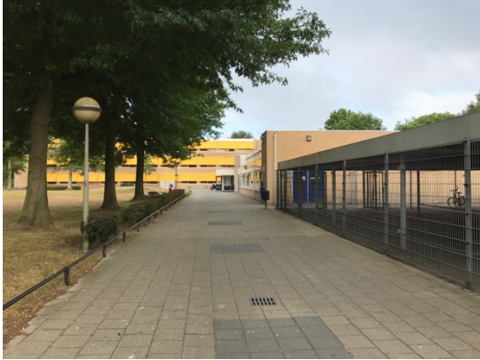
Voormalig schoolgebouw gezien v.a. de Zangvogelweg
