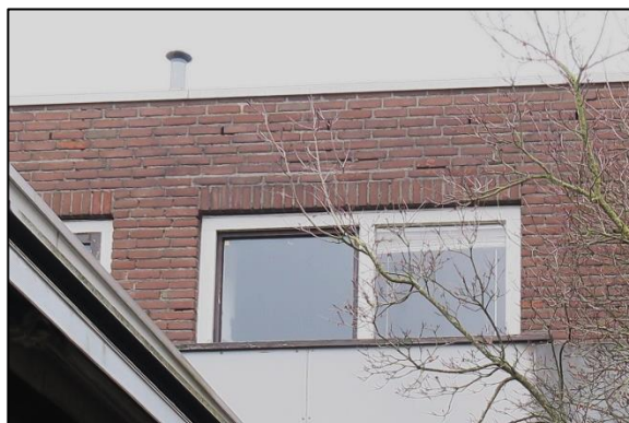
Foto 6. Open stootvoegen boven ramen van appartementen
