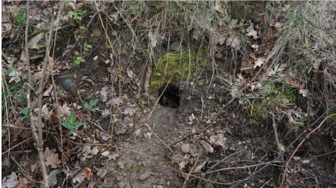
Figuur: in de greppel langs de spoorberm zijn diverse hopen aanwezig van bruine rat.
