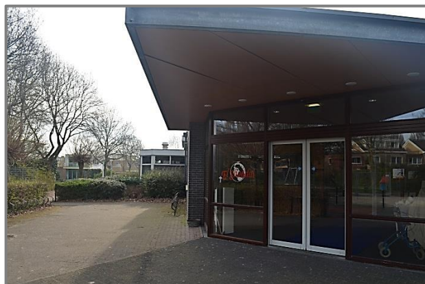
Afbeelding 2.6 | Vooraanzicht voormalige bibliotheek met links direct tegen het gebouw te verwijderen struiken.
