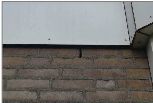
Afbeelding 2.4 | Openstootvoeg en de ontoegangelijke boeiboorden.
