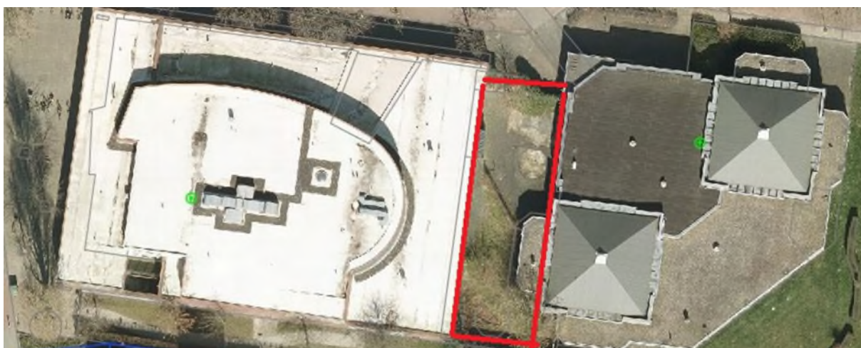
Afb. 1. Projectlocatie met links de bibliotheek/het dorpshuis (Engweg 7) en rechts (het huidige gebouw op) de toekomstige bouwlocatie (Engweg 9). De rood omrande locatie gaat gebruikt worden voor de entree van de nieuwbouw.
