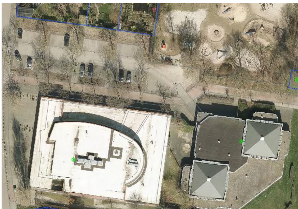
Afb. 1. Winterbeeld projectlocatie met linksonder de bibliotheek/het dorpshuis (Engweg 7) en rechtsonder (het huidige gebouw op) de toekomstige bouwlocatie (Engweg 9). Het huidige fietspad ligt op het Struweelpad, dat van oost naar west vlak langs de huidige bebouwing gelegen is. Linksboven is de parkeerplaats te zien met de onderzochte bomen.
