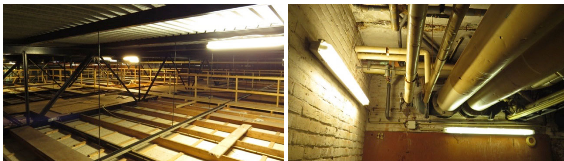
Figuur 2. Nok (links) en machinekamer (rechts): 100% afgesloten van de buitenruimte.
