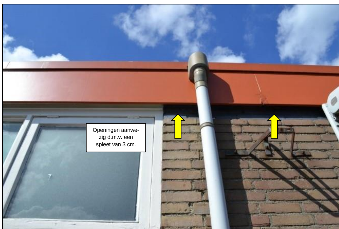
Figuur 4. Betimmering aan de bovenzijde van de fysiopraktijk.
