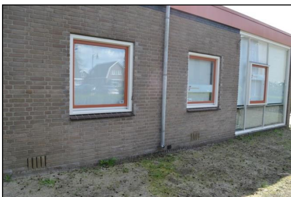
Figuur 5. Gevel aan de noordzijde van de onderzoekslocatie.
