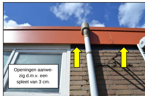
Figuur 9. Betimmering aan de bovenzijde van de gevel.
