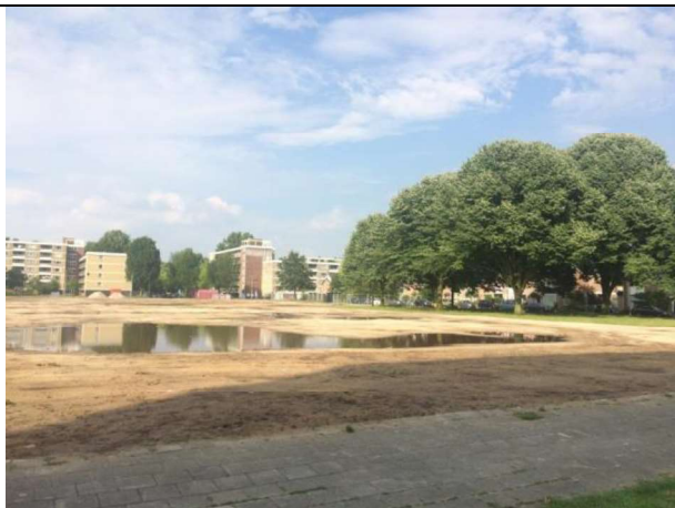
Zicht op bouwterrein
