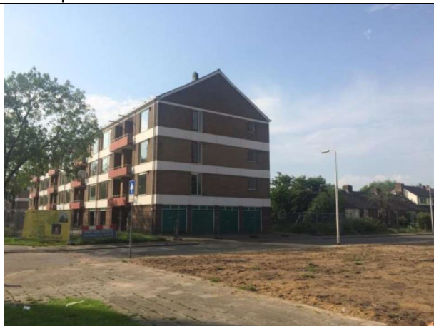
Kopgevel flat wiekslag (renovatie)
