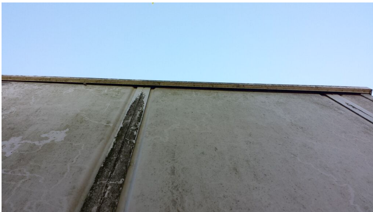
Close-up wandpanelen, alle kieren zitten dicht met rubberen strips.
