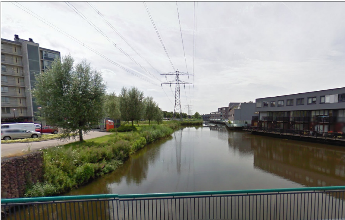
Figuur 18: Hoogspanningslijn door Nieuwland gezien vanaf de brug over de Libelle
