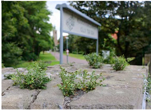
Muurvaren op gemetselde pilaren bij de entree naar het klooster
