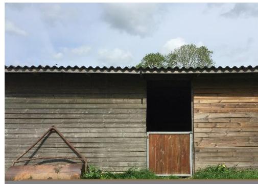
Foto 4: Bebouwing waar uitwerpselen gevonden zijn
