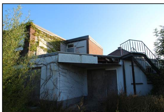
Foto 2. Achterzijde te slopen woning
