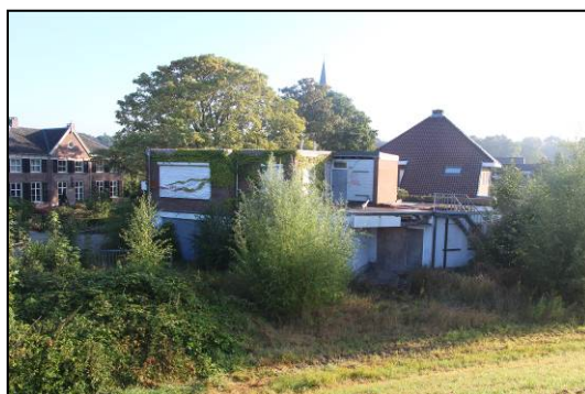
Foto 7. Plangebied vanaf dijk
