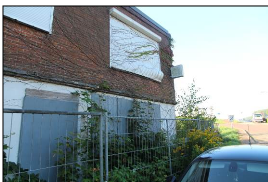
Foto 1. Voorzijde te slopen woning
