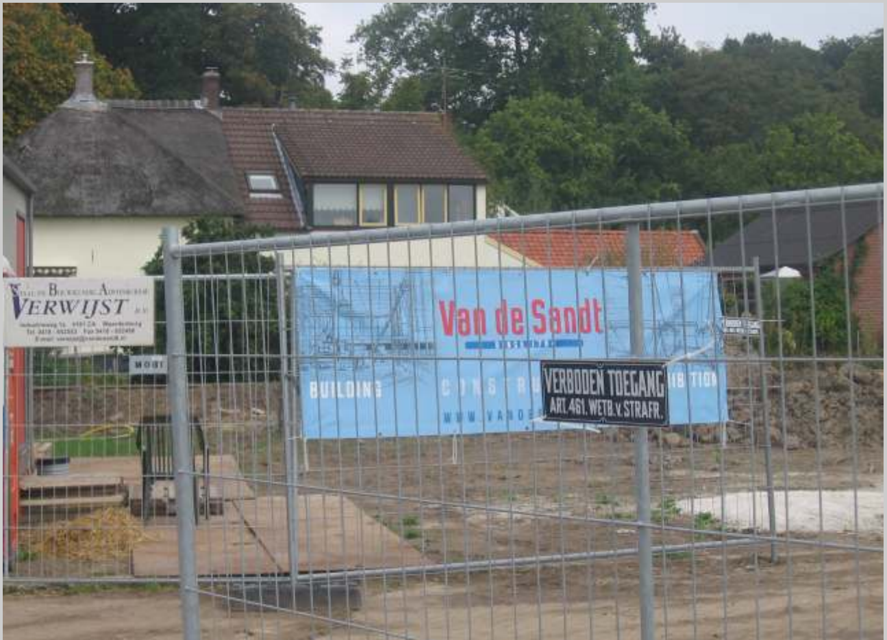
Uitvoering herbouw boerderijwoning
