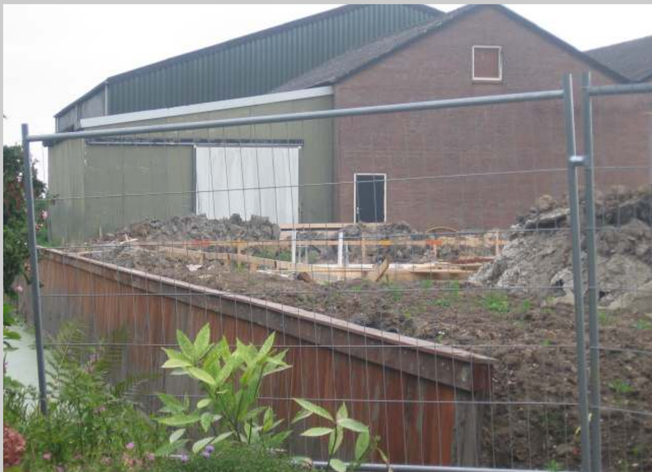
Nog te slopen bedrijfsbebouwing
