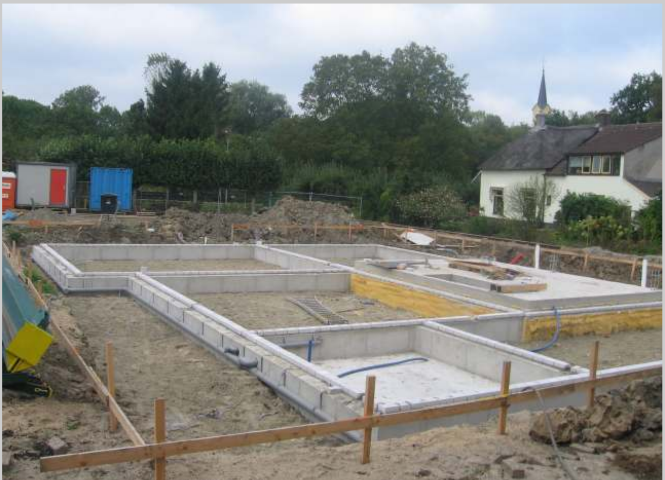
Contouren en fundament herbouw boerderijwoning (2009)
