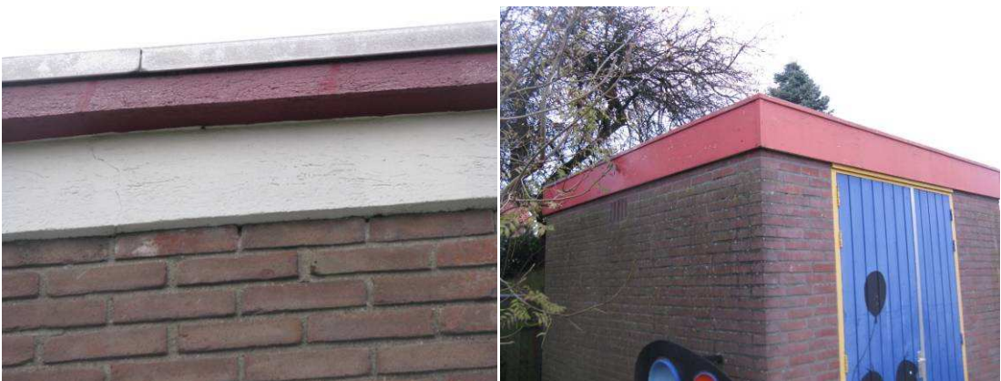
Afbeelding 5.2. Gebouwen met een plat dak (links de betimmeringen van het schoolgebouw en rechts het opberghok).
