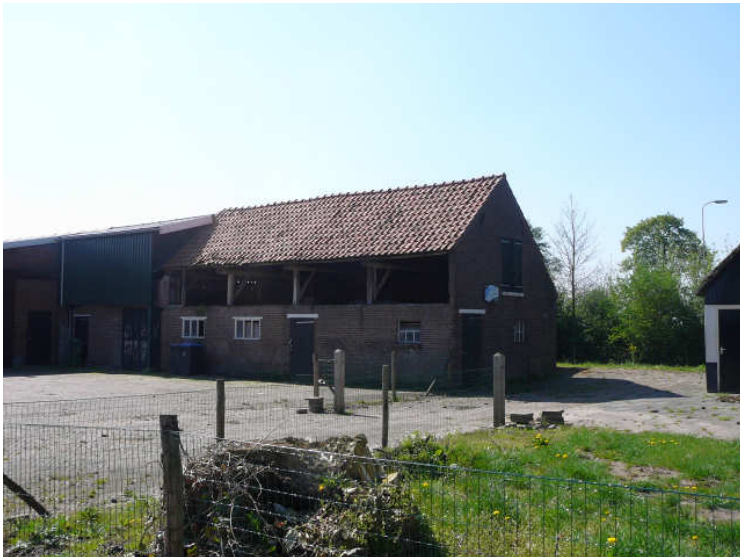
foto 2 bijgebouw (wordt gesloopt)
