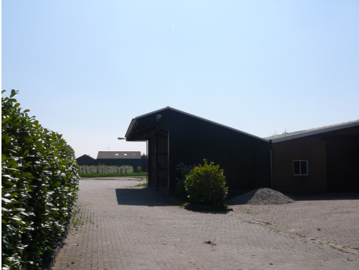
foto 1 Bijgebouw (wordt gesloopt)
