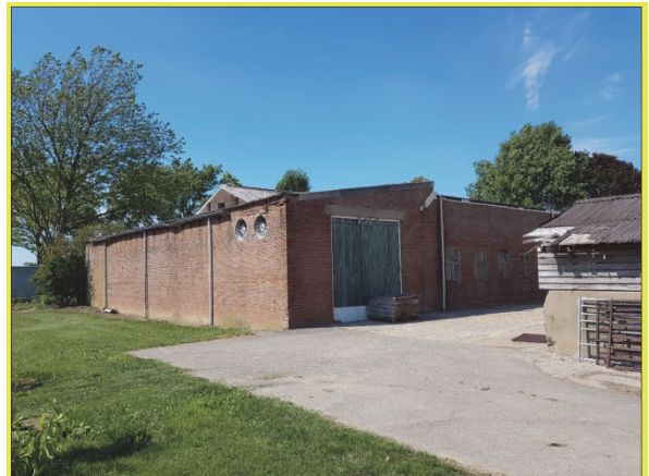
Figuur 14. Zuidzijde te slopen bedrijfsloods
