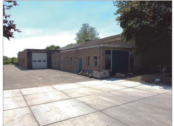
Figuur 12. Te slopen bedrijfsloods, gezien vanaf de Ophemertsestraat
