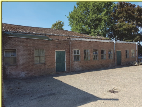
Figuur 13. Oostzijde te slopen bedrijfsloods
