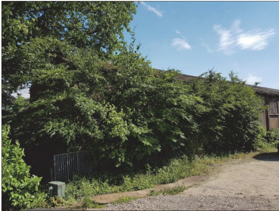
Figuur 15. Opgaande beplanting langs te slopen bedrijfs- loods
