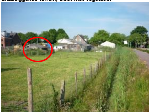
Overzicht erf B, Bernhardstraat 40, en schuur A (rode cirkel)
