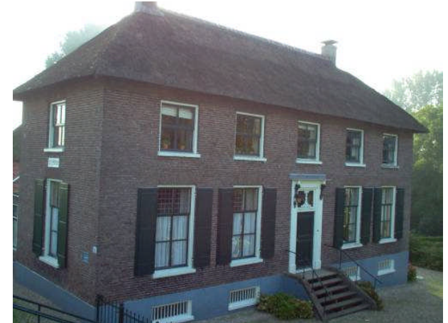
Referentie gevel hoofdgebouw
