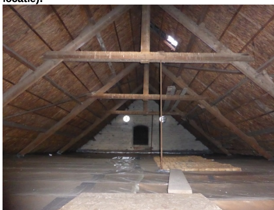
Zolder monumentale schuur, afgedicht, gesaneerd op asbest (buiten locatie).
