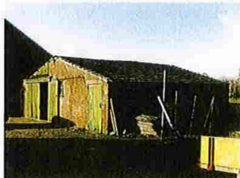
schuur met gifhok en vml. tank Bernhardstraat 44
