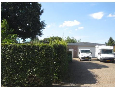
Te handhaven bijgebouw
