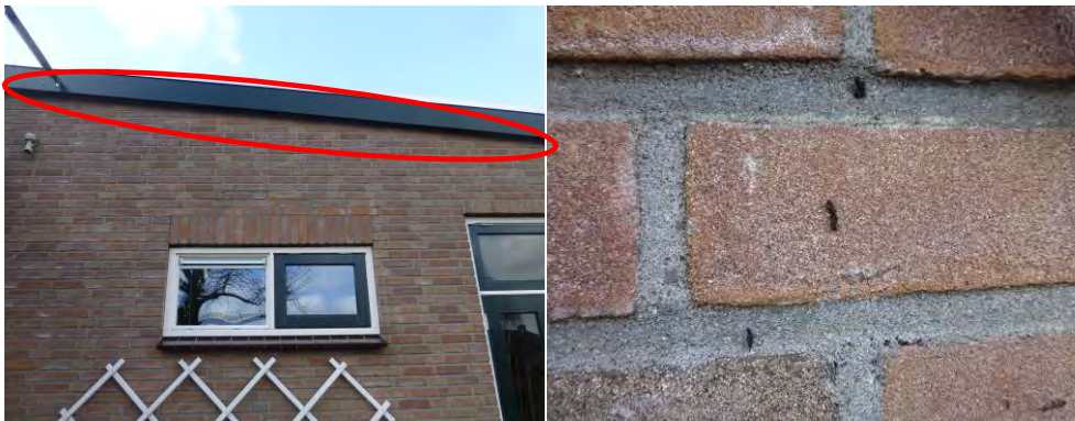
Figuur 8. In het gebouw in het plangebied vormen ruimtes, kieren en boeiboorden in potentie geschikte vaste rust- en verblijfplaatsen van vleermuizen. Rechts zijn de op de locatie van de linker foto aangetroffen vleermuisuitwerpselen weergegeven.
