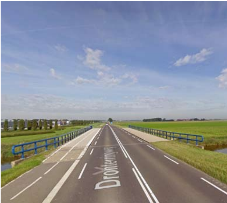
Bestaande brug Lage Vaart
