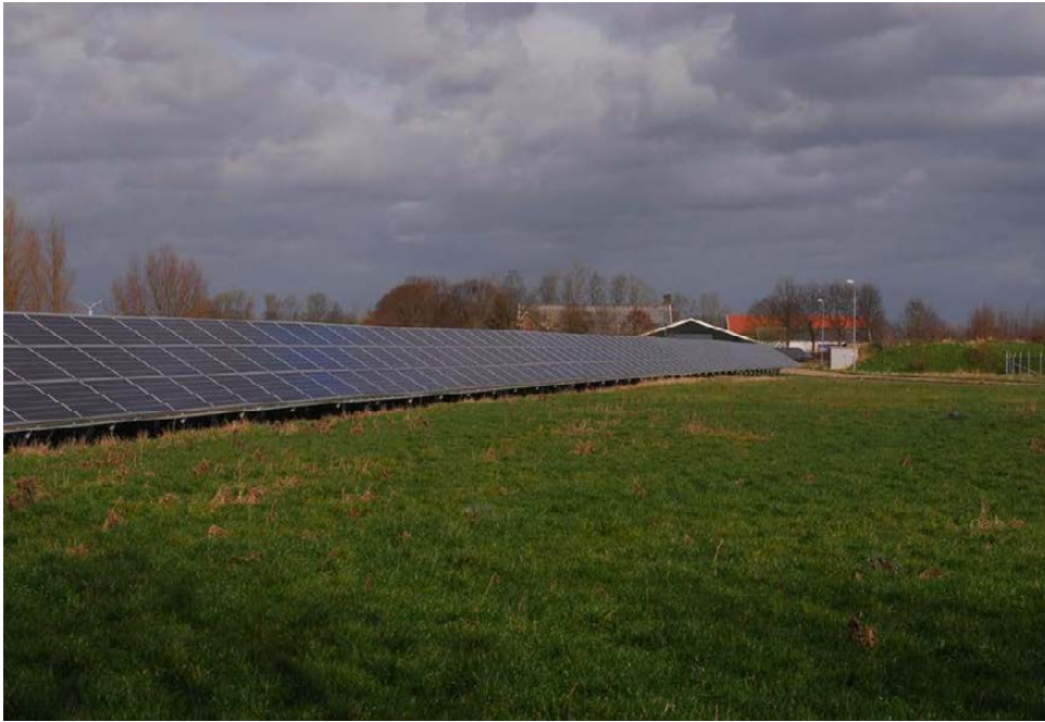
Figuur 6 Aanzicht vanaf de noordzijde (Mosselweg)
