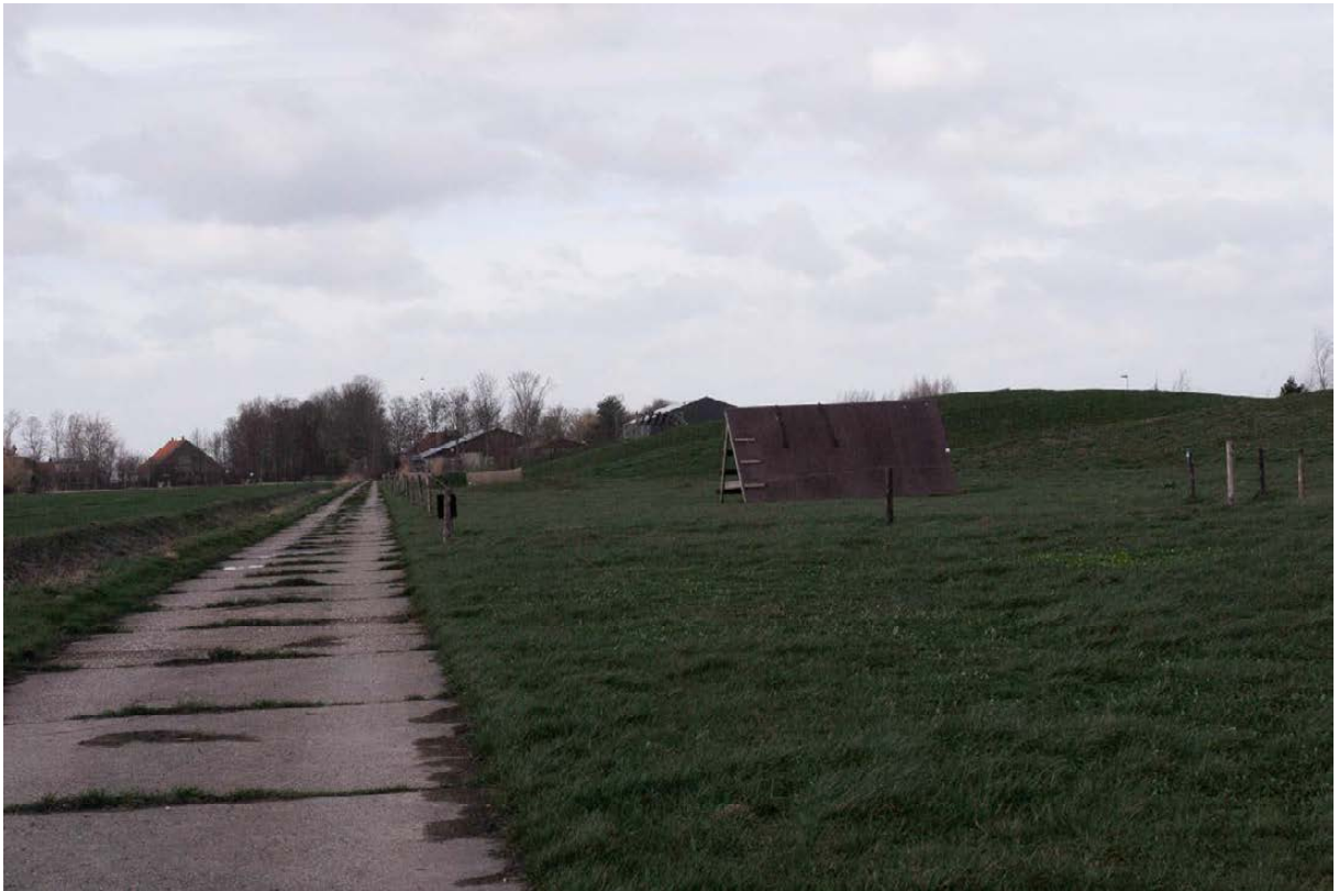
Terrein Flevonice, westzijde, zicht op de noordwesthoek met boerderij.
