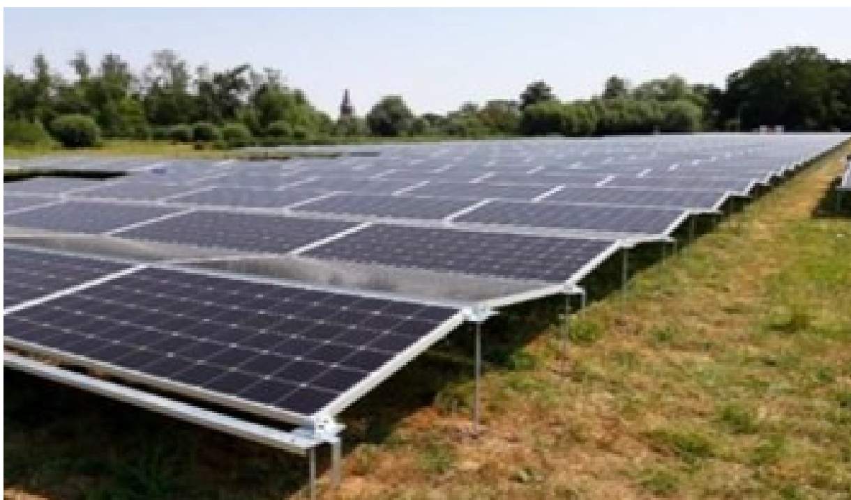
Richtbeeld panelen op maaiveld
