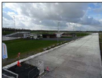
Figuur 8. Aanzicht ijsbaan in het midden van de onderzoekslocatie.
