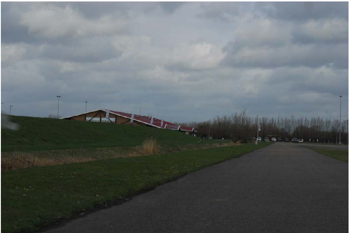
Terrein Flevonice, bestaande parkeerplaats in het uidwestelijke deel met zicht op het hoofdgebouw.
