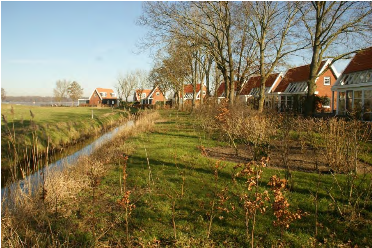
Figuur 5.3 Op de schouwstrook is beplanting aangebracht
