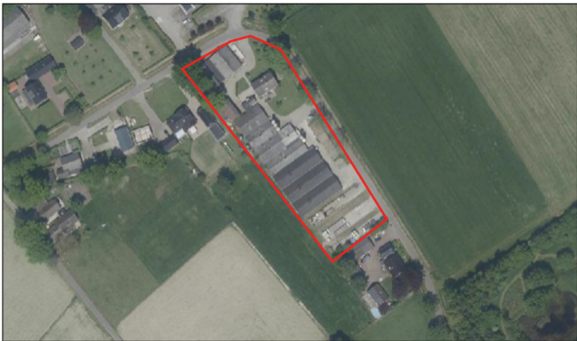
Afbeelding 2.1: Luchtfoto huidige situatie plangebied (Bron: PDOK)
