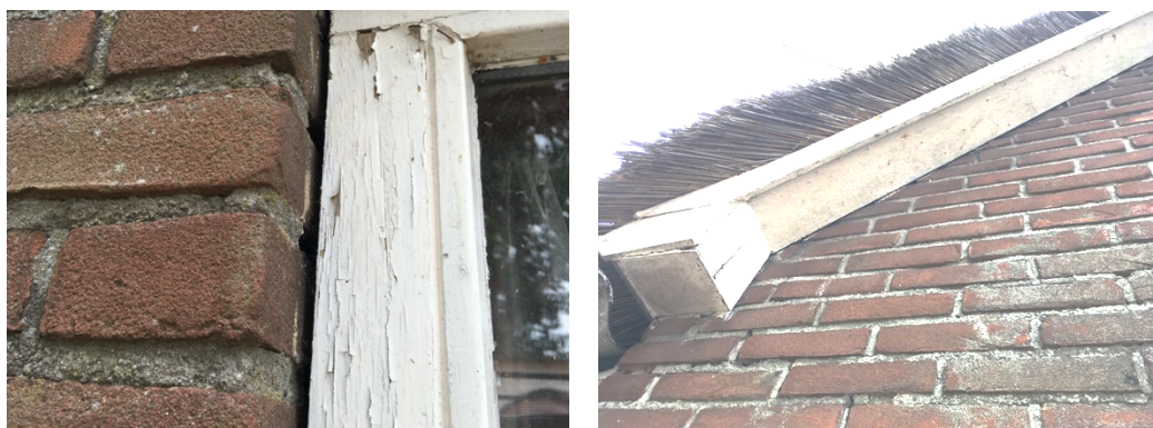
Figuur 10 & 11. Potentielle ingangen voor vleermuizen tot verborgen ruimten met links een kierend kozijn en rechts een kierende daklijst.
