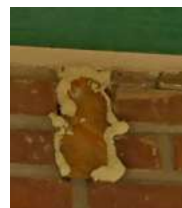
Openingen dichtgezet met pur
