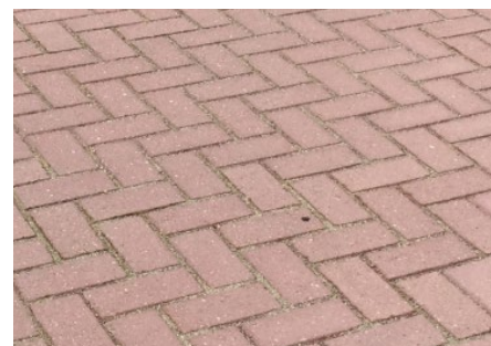
Referentiebeeld betonklinkers in keperverband
