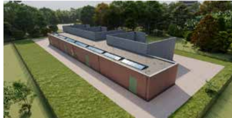
Installatiegebouw Liander met transformatoren in open ruimtes van beton.
