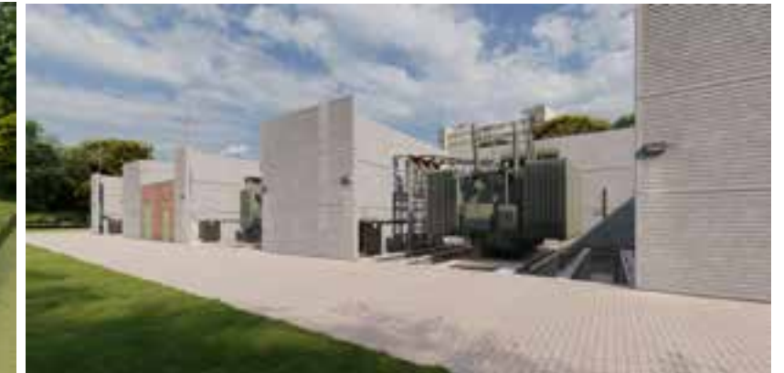
Installatiegebouw Liander met transformatoren in open ruimtes van beton.
