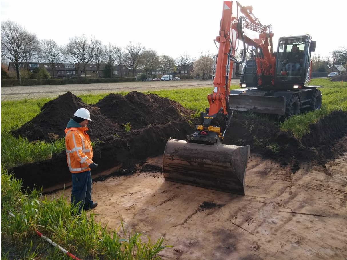
Figuur 4. De aanleg van het vlak.
