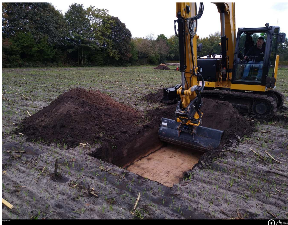
Figuur 5. Aanleg van profielputten met midi-kraan.
