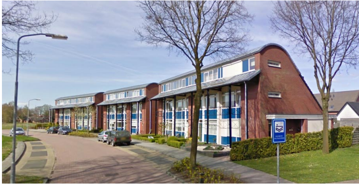
Bestaande woningen met veranda langs de Dominee Lamensweg
