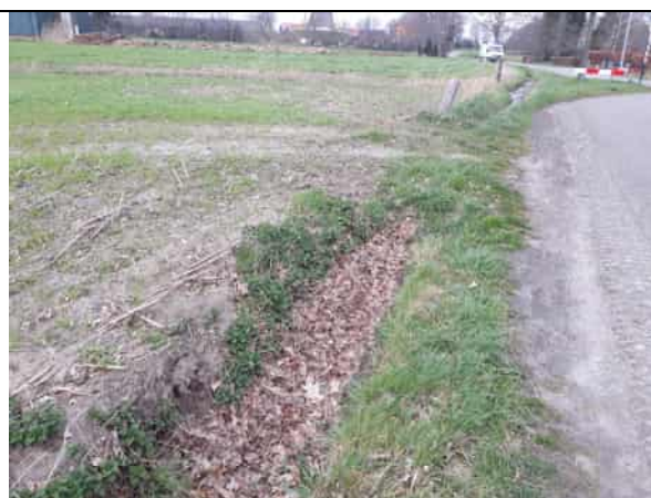
Dammetje perceel B5818 - Hullerweg
