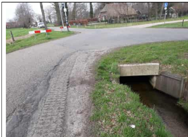
Kruising Hullerweg – Moelnweg met duiker onderdoor
